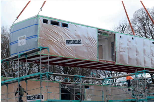
am 10. Februar 2016 wird der 1. Stock der neuen Interimsklinik aufgebaut,
